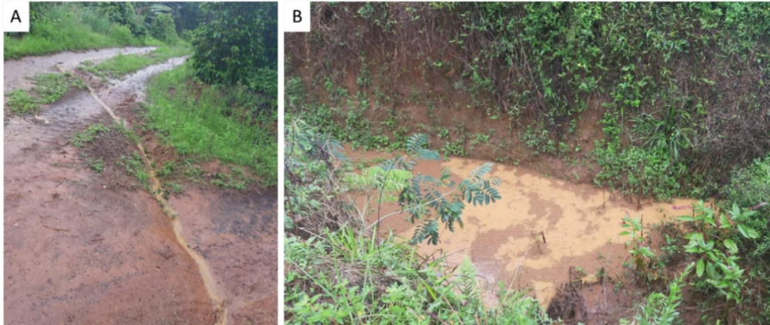
Figura 8: Construção de barraginha. A) Desníveis da água escoada nas estradas para as barraginhas.
